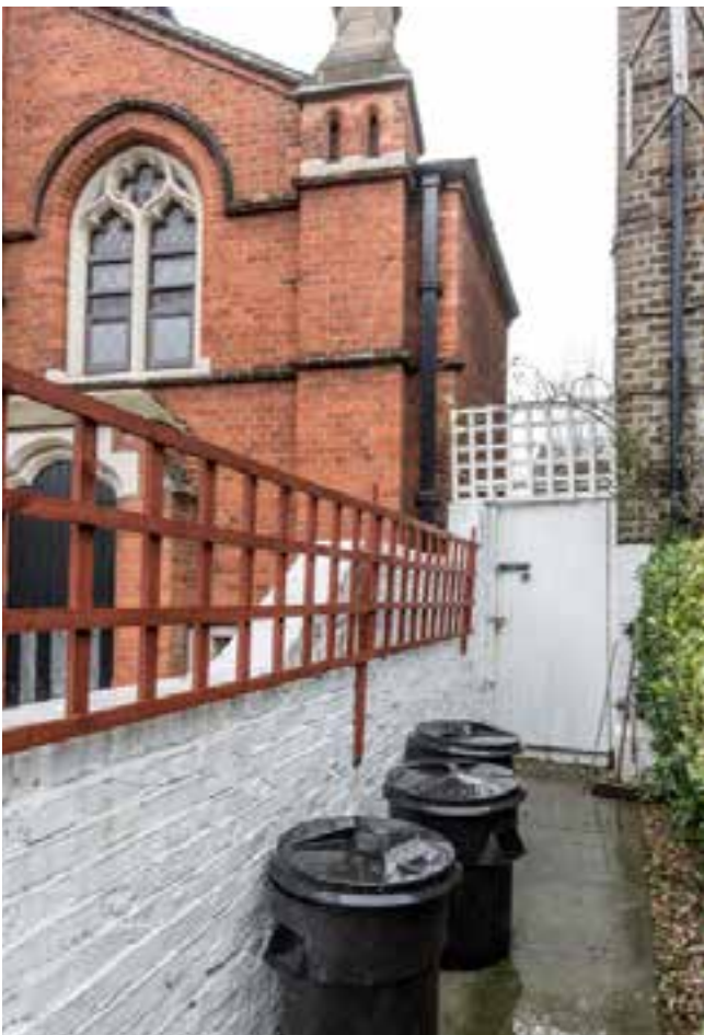
Gemensamma ytor före och efter uppgradering 55 Croxley Road, London
